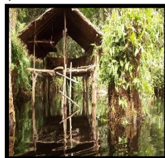
Figure 58: Toilettes suspendues/Sur Pilotis
