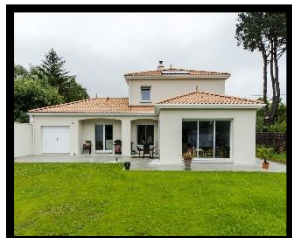
Figure 13: Toiture en tuile
