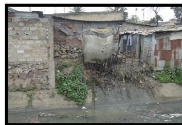
Figure 60: Toilettes Cours d'eau
